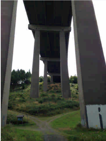
Unter der Rinsdorfer Autobahnbrücke: Deren Erneuerung steht als erstes Großprojekt an.
